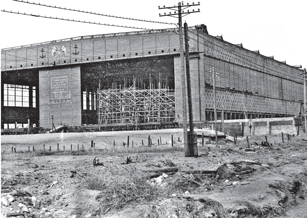
В недостроенном цехе 50 строились линкоры
