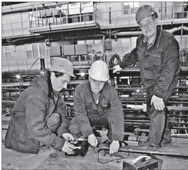
В.Т. Цуркан, С.А. Брагин, мастер А.И. Андриевский замеряют сопротивление изоляции кабеля на АПЛ «Александр Невский»
