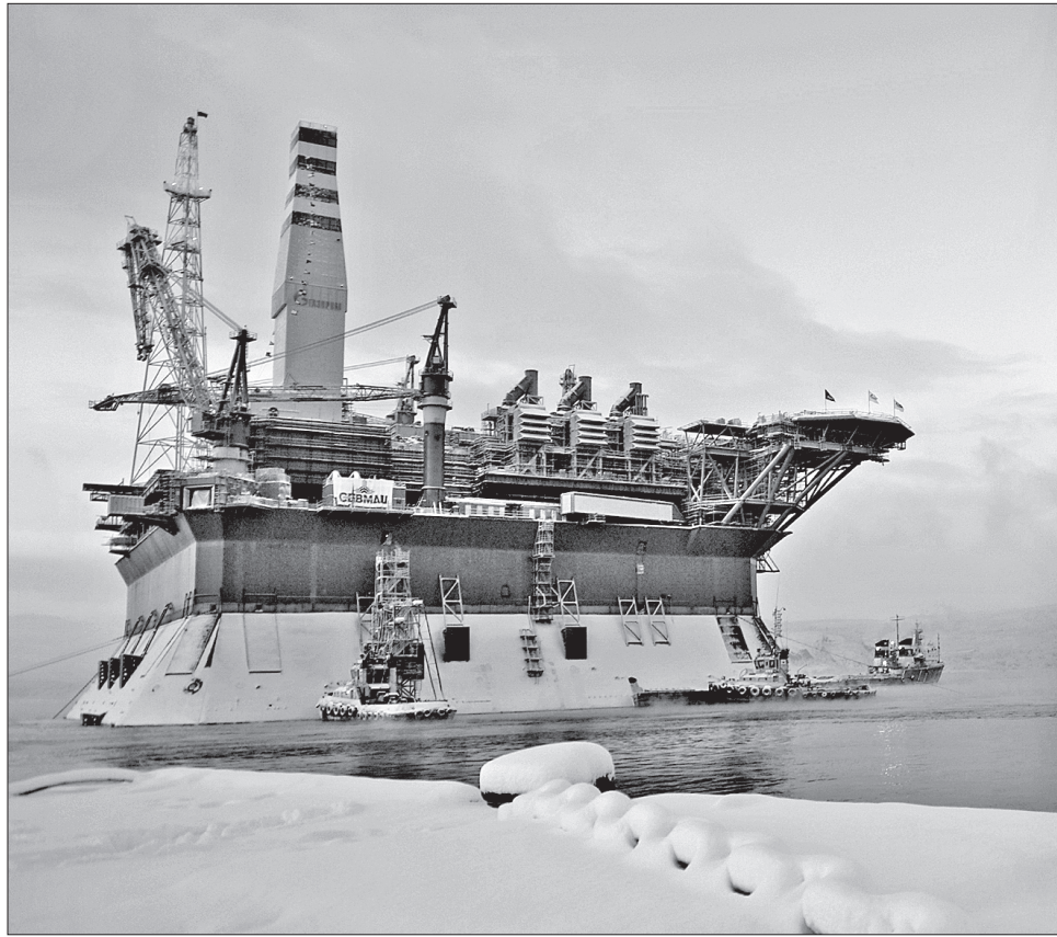
МЛСП «Приразломная» у причала 35-го судоремонтного завода
