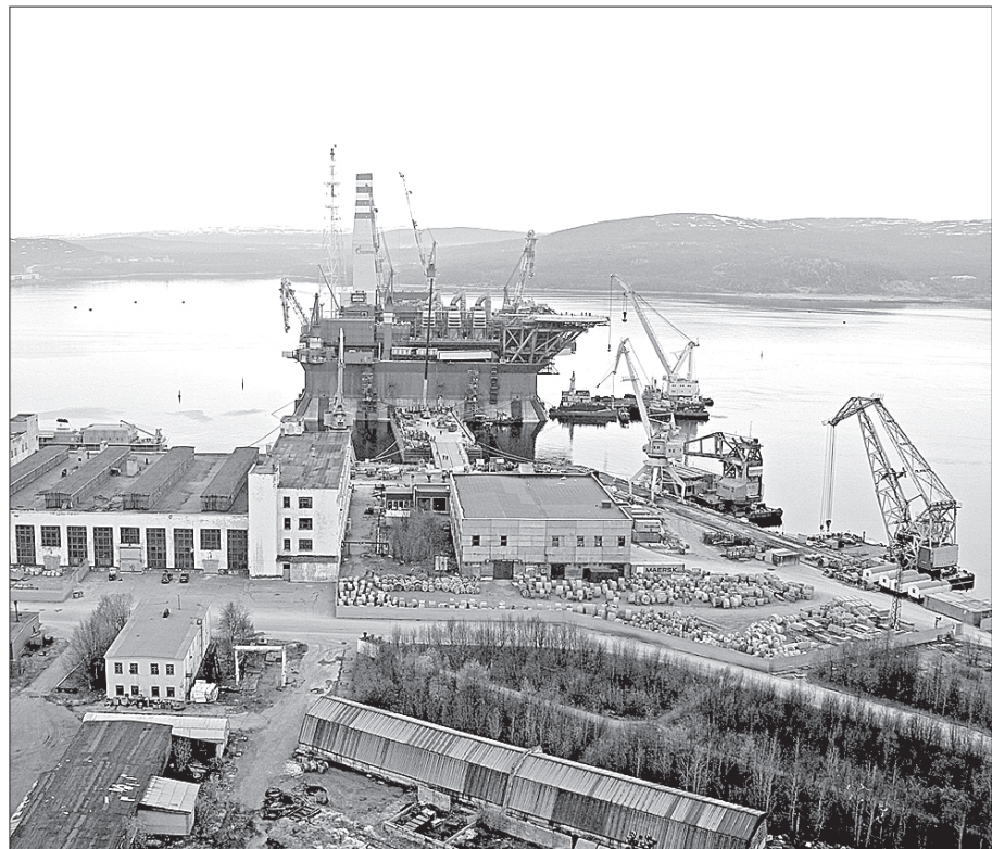
В Мурманске на «Приразломной» полным ходом идут работы
